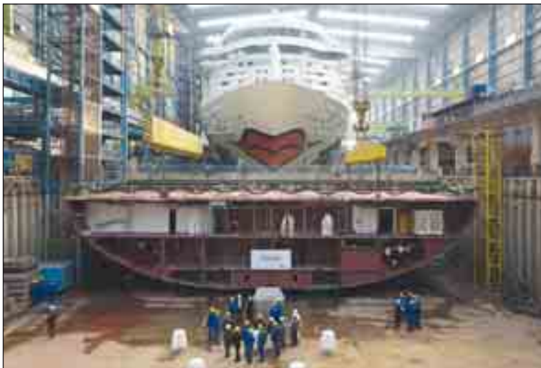
Produktionshalle der Meyer Werft GmbH in Papenburg
